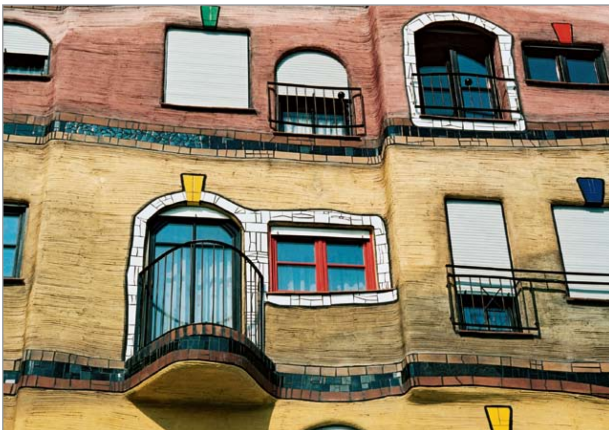
SILSiga soojustatud hoone – soojuskaitset saab SILSi abil teostada ka siis, kui hoone kujundamine nõuab suurt arhitektuurilist vabadust.
