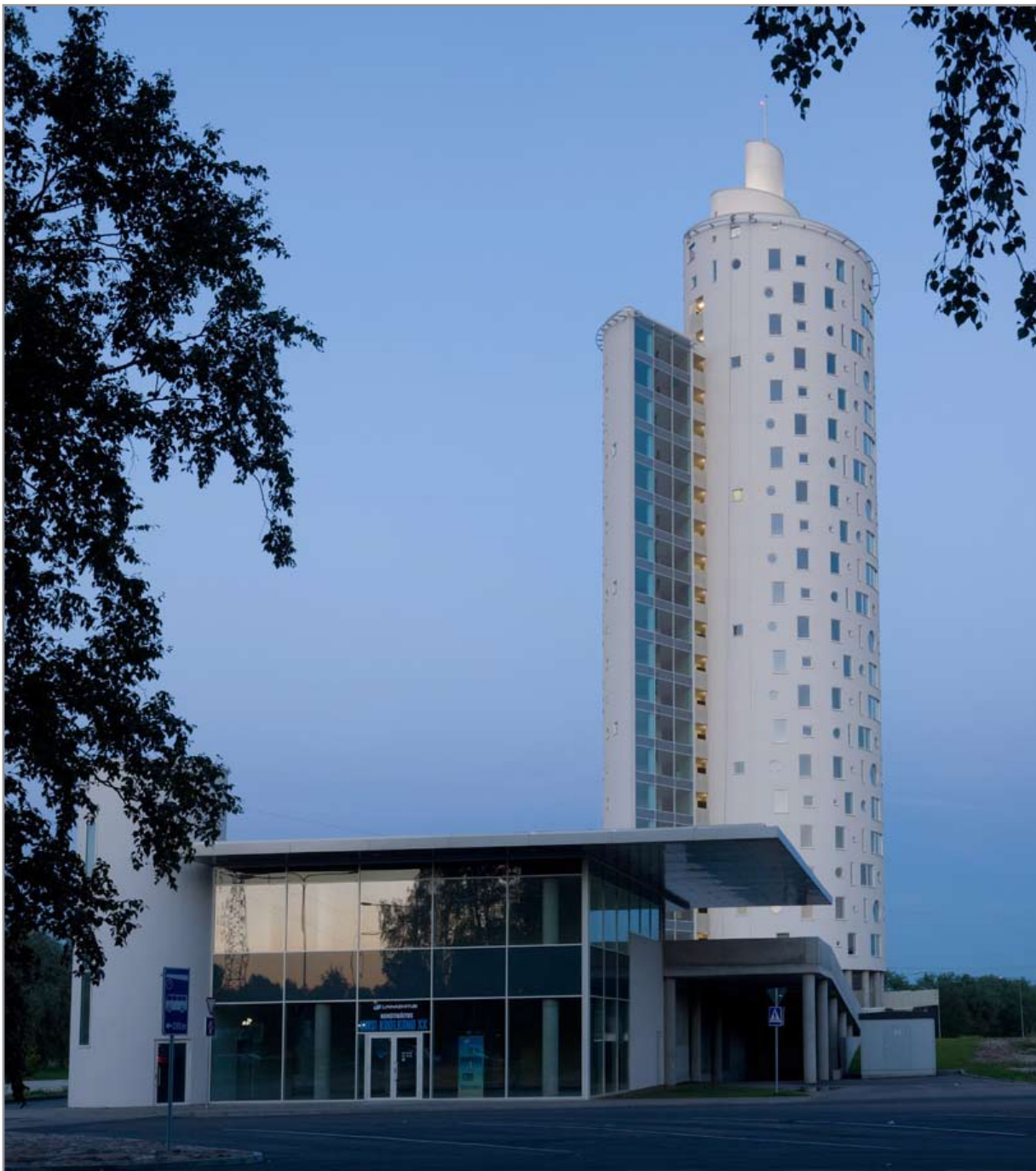
Pilt 1. Korralikult paigaldatud SILS on ohutu ja kauakestev vähest hooldust nõudev fassaadisüsteem. Tartu Tigutorni puhul on SILSi kasutatud kumera seina soojustamiseks.
