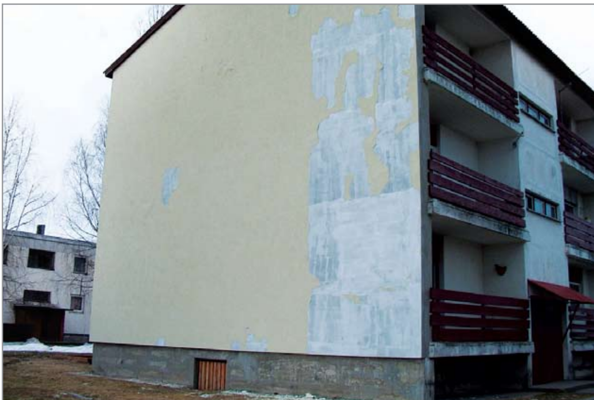
Pilt 4. Sein on krohvitud sügisel niiskel ja külmal ajal. Tööde teostamisel ei kasutatud tellin-gukatteid ja krohv külmus enne lõpliku kuivamist läbi. Tulemuseks on krohvikihit, mis eraldub juba aasta möödudes aluspinna küljest.
