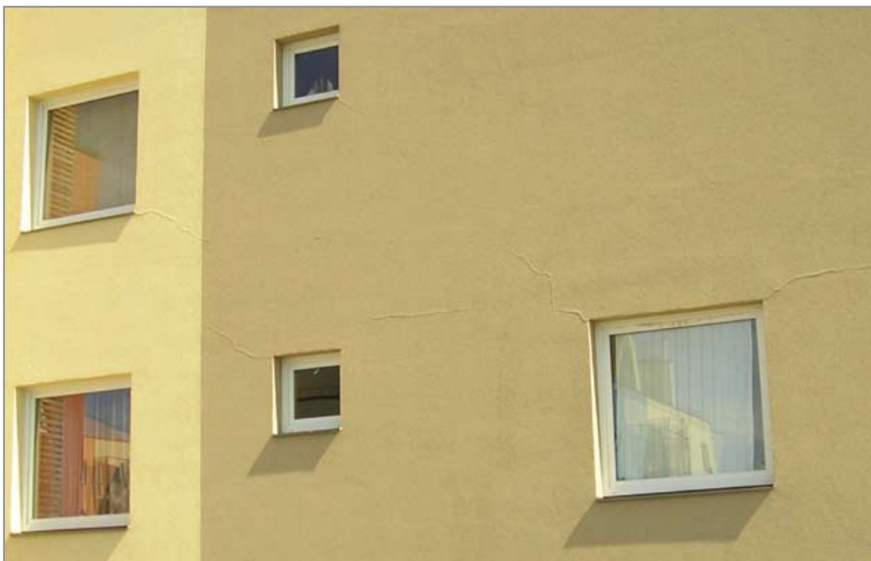
Pilt 2. Valesti paigaldatud SILS. Vahtpolüstüreenplaadid on liimitud liimipätsikestega, mitte servpunkt-meetodil. Tulemuseks on liimühenduse katkemine ja pragude teke.
