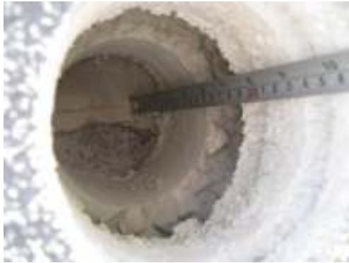
Joonis 3.4 Vahtpolüstüreeniga soojustatud hoone proovikeha puurimine
